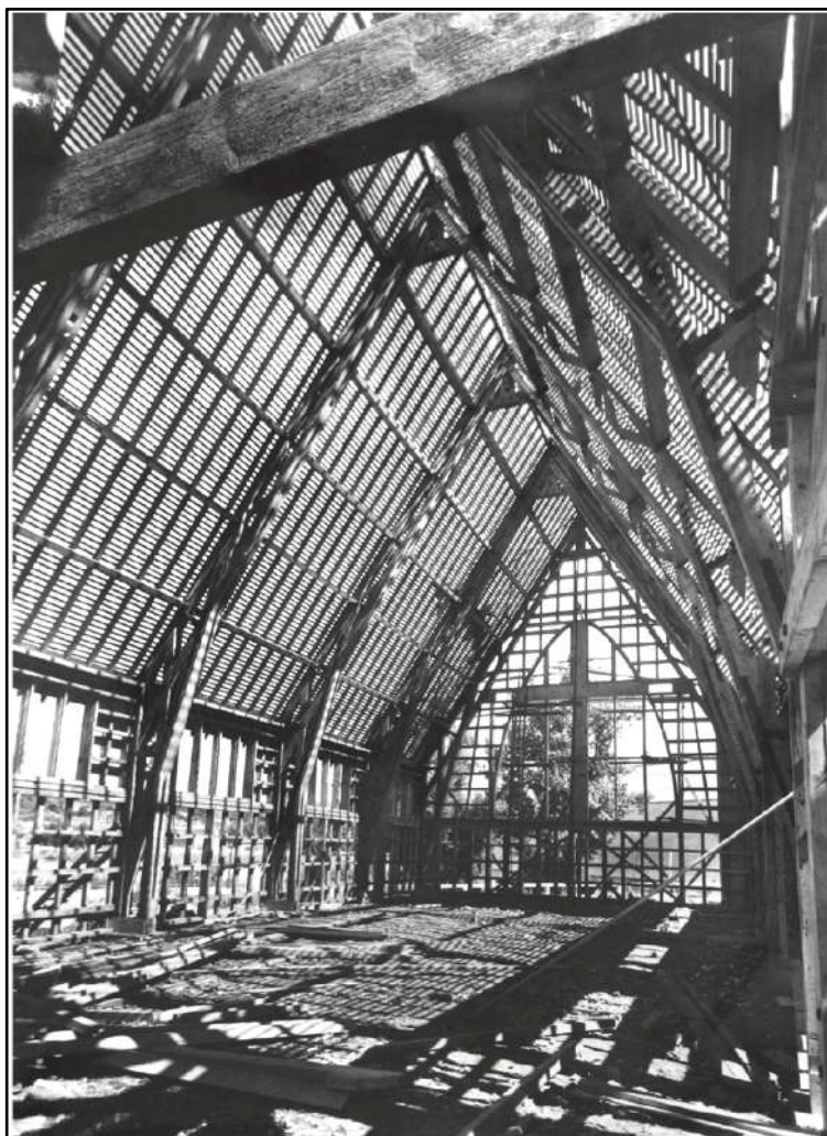
Remontage de l'église à Lavancia-Epercy, 1952. © Arch. dép. des Côtes-d'Armor.
