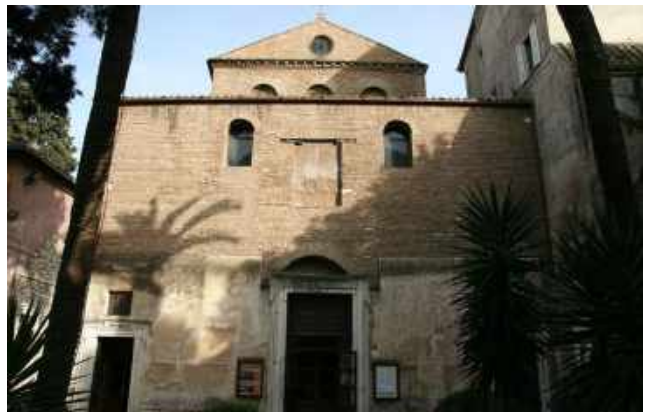
Basilique Sainte-Agnès-hors-les-Murs Rome
